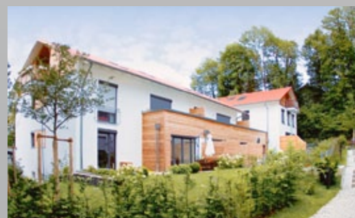
Oberhaching, Kybergstraße 23 Einheiten (DHH / RH / WE) – Fertigstellung 2010/11
