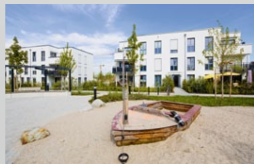
München-Riem, Den-Haag-Straße 53 Einheiten (WE) – Fertigstellung 2015
